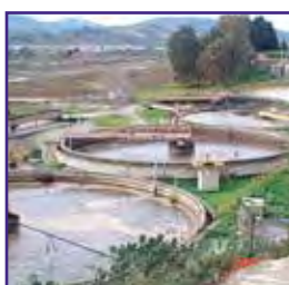
Traitement de l'eau
