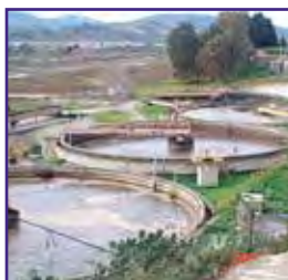
Traitement de l'eau
